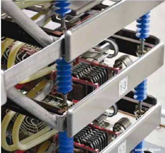
รูปที่ 7.22 Thyristor Valves
