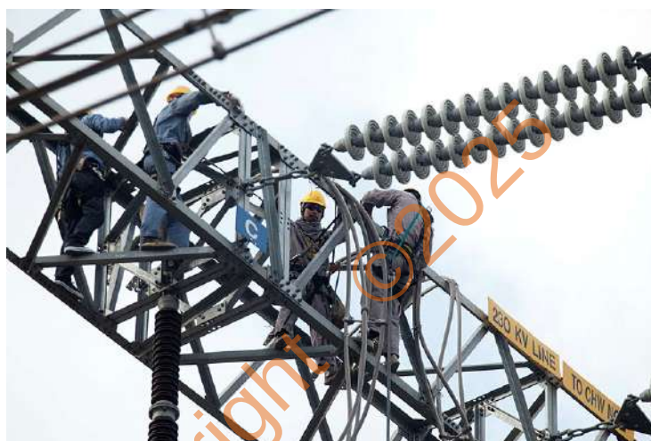
รูปที่ 3.26 การติดตั้งตัวนำไฟฟ้า (Conductor) 230 kV
