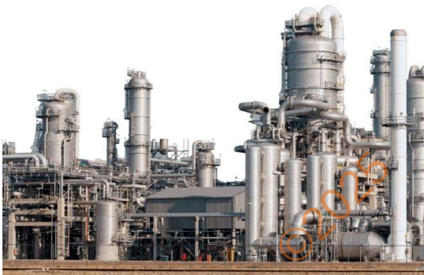
รูปที่ 2.6 โรงไฟฟ้าก๊าซธรรมชาติ (Natural Gas-fired Power Plant)
