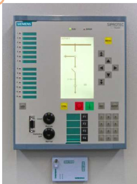
รูปที่ 6.3 รีเลย์ป้องกันแบบดิจิทัล
