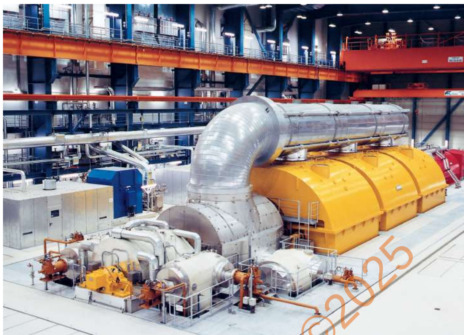
รูปที่ 2.4 Turbo Generator ที่มา https://uee.com.eg/industries/
