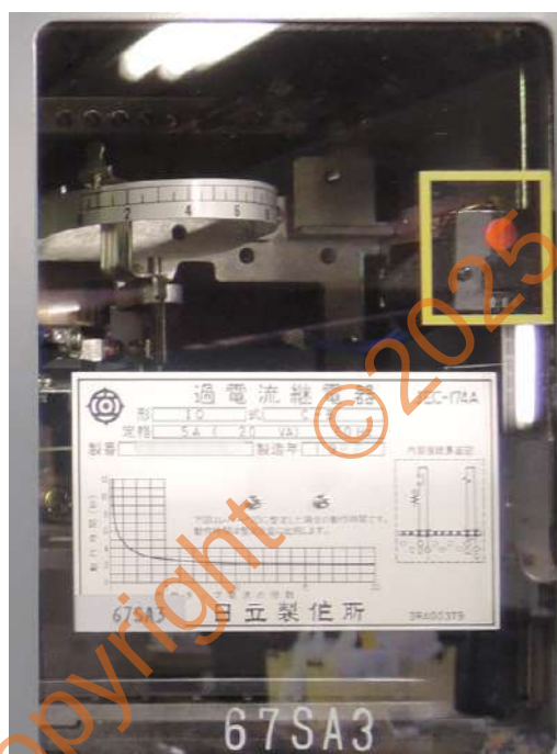
รูปที่ 6.2 มิเตอร์แบบดิสก์เหนี่ยวนำ
